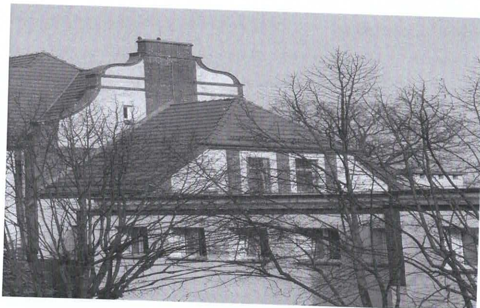
Elewacja południowa część 2
