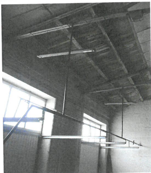
zdj. 4.: istniejące bramy i okna od strony wewnętrznej
