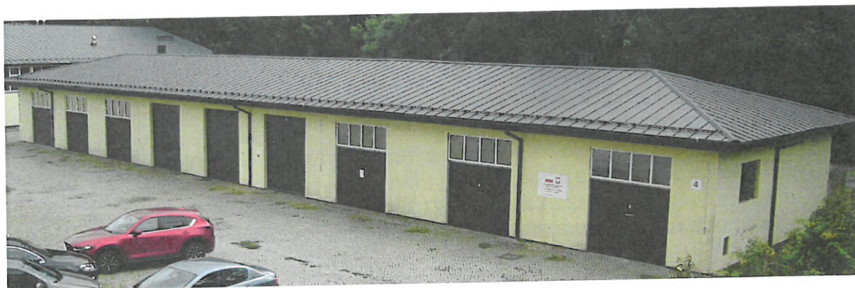
zdj. 1.: ogólny widok budynku
