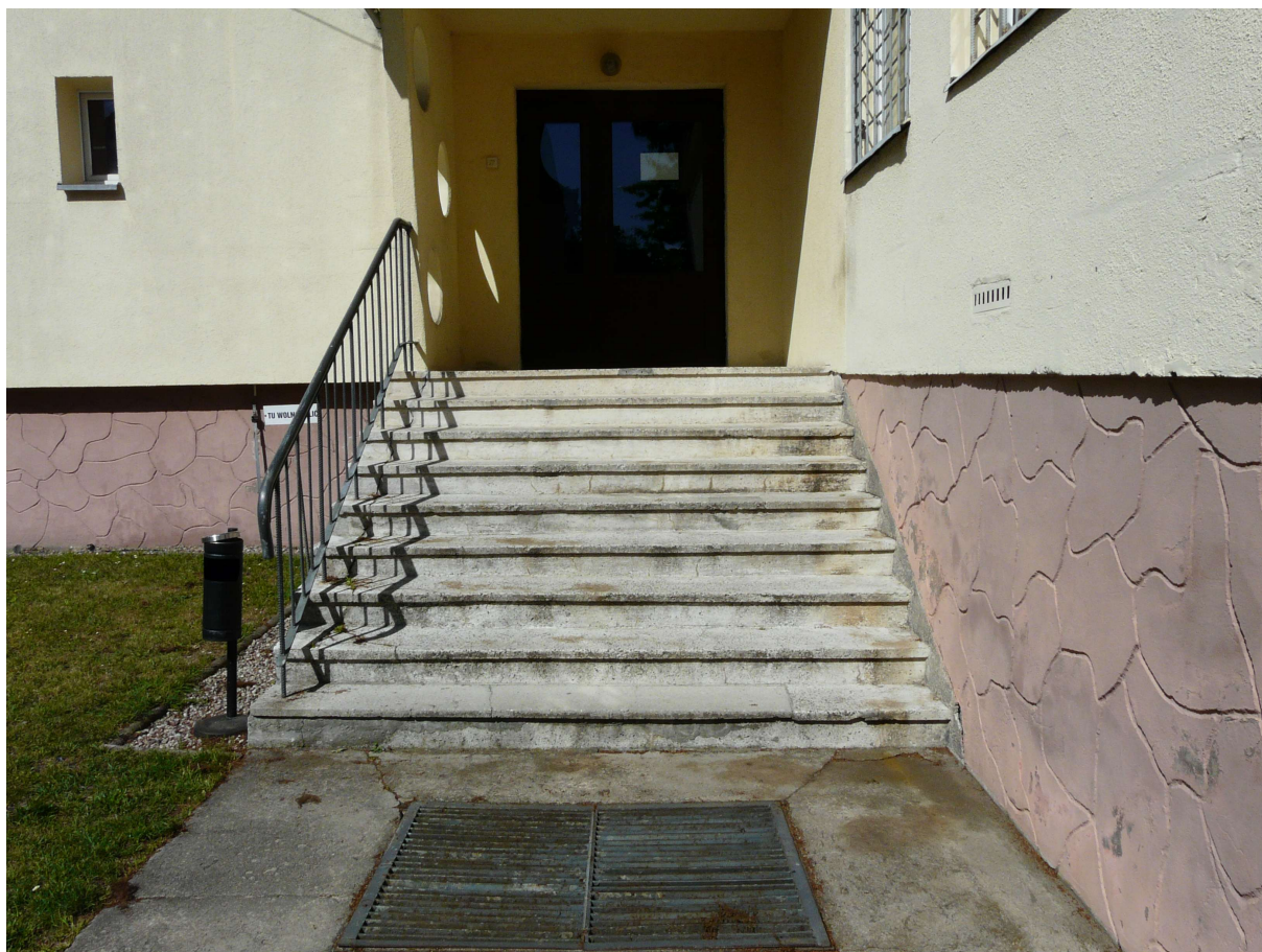
zdj. 1: widok ogólny schodów przeznaczonych do remontu
